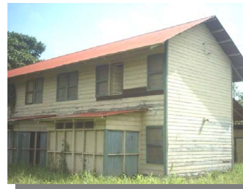
Fotografía No.1.5 Vivienda de madera tipo Yarda. Esta clase de vivienda era ocupada por los trabajadores solteros de clase obrera de la Compañía Bananera.
