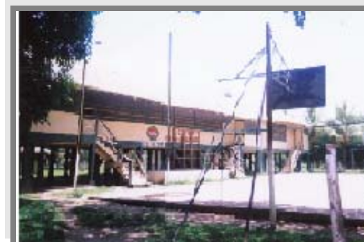
Fotografía No. 4.15 Vista exterior de una edificación escolar, ubicada en la finca Arapahoe.
