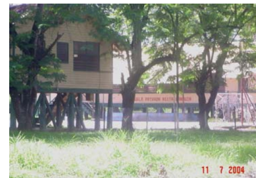
Fotografía No. 4.14 Vista exterior de una edificación escolar ubicada en la finca Lanquín 1.
