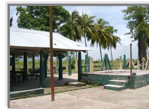
Fotografía No. 4.17 Escombros de lo que fue la escuela de la finca TIKAL
