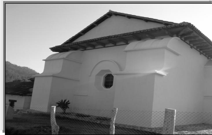
Fotografía: 3.1 (F-54) En la imagen la fachada posterior de la iglesia colonial, en la cual se puede apreciar la terraza española con molduras de pecho de paloma en las vigas que la componen así mismo podemos apreciar la ventana abocinada de forma octogonal al centro de la misma, como también los torreones a cada uno de los extremos de la misma.
