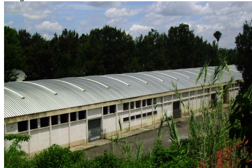
Fotografía tomada en visita al Instituto Técnico Vocacional Dr. Imrich Fischmann, Guatemala, se puede observar un módulo que alberga varios talleres.
