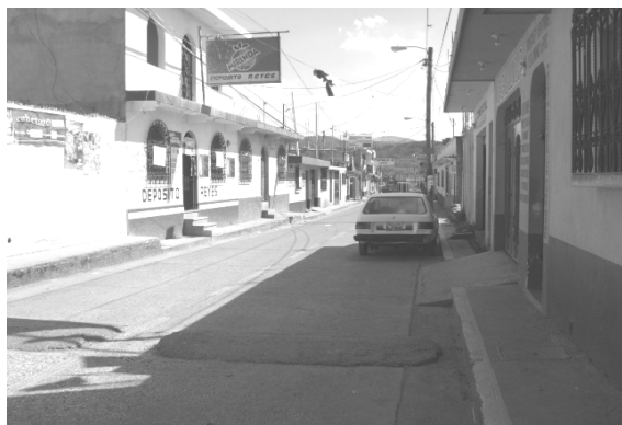
Fotografía 17: 2ª. avenida pavimentada con concreto.
