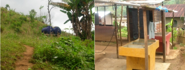
Fig. 70 Las dos pilas existentes, están sin usar ya que estas no cuentan con conexión de sistema de abastecimiento para dotarla de agua, por lo que no se hace uso de ellas.
