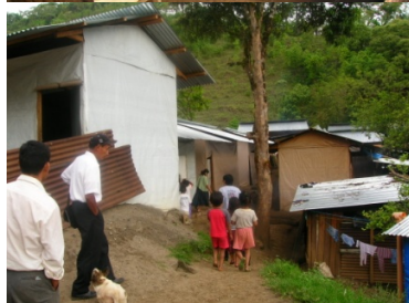
Fig. 60 La fotografía presenta taludes mínimos, pero son puntos de convergencias de escorrentías, el área se ubica en los arranques de una colina pequeña causando vulnerabilidad psicológica.
