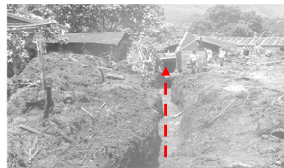
Figura 23 Fuente: Archivo personal Cuneta de 0.40 m X 0.40 m aguas debajo de El Calvario.
