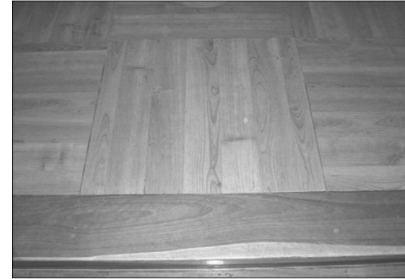
Fotografía 3. Superposición de piso laminado de madera. Elevación del nivel y Elementos agregados. Alteración Conceptual y Alteración Espacial.
