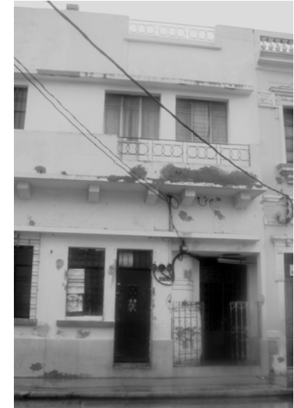
Foto 9: edificación categoría "C".
