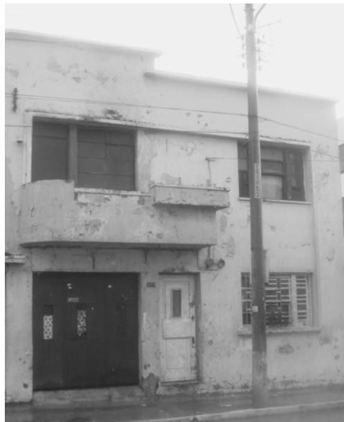
Foto 12: edificación categoría "C".
