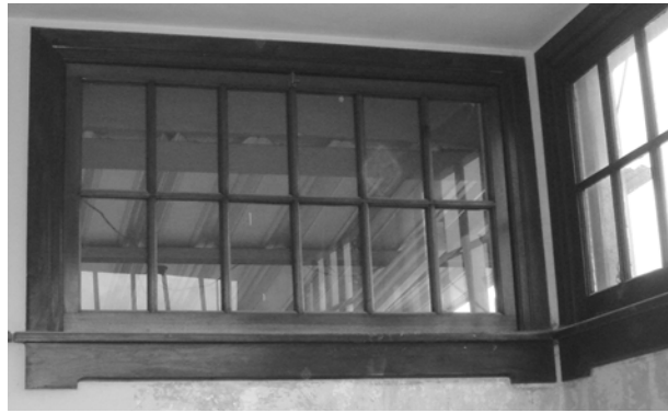
Fotografía 22: Ventanería de las gradas de servicio hacia la terraza, Registro de la Propiedad Fuente: Fotografía tomada por el autor.
