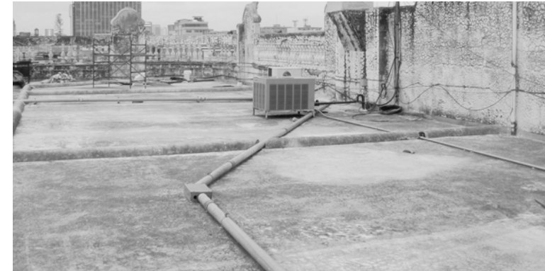
Fotografía 18: losas Registro de la Propiedad Fuente: fotografía tomada por el autor.
