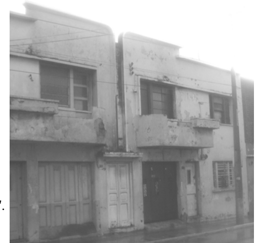
Foto 13: edificación categoría "C".
