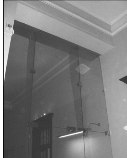
Fotografía 13. Puerta de vidrio templado. Elementos agregados. Alteración Conceptual.
