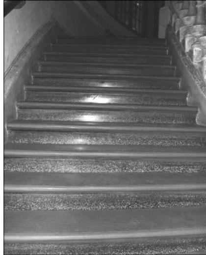
Fotografía 12. Superposición de piso (material antideslizante). Elementos agregados. Alteración Conceptual.
