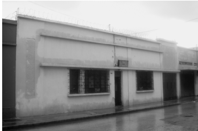
Foto 11: edificación categoría "C".
