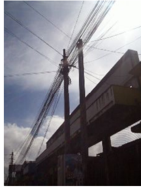
Fotografía No. 11. Ave. Bolívar.
