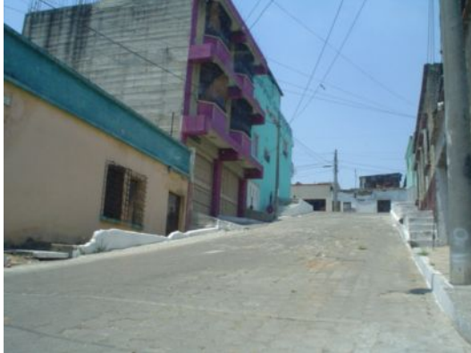
Fotografía No. 5. Vista de Calle Ubicada en la 30 Calle “B” entre 1era y 2da Avenida de la zona 8.
