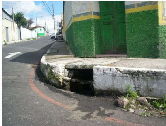
Fotografía No. 6. Vista de Banqueta Ubicada en la 31 Calle y 7ª. Avenida de la zona 8.
