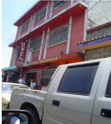
Fotografía No. 4. Ubicada entre 31 Calle "A" y 31 Calle en la 2da Avenida.
