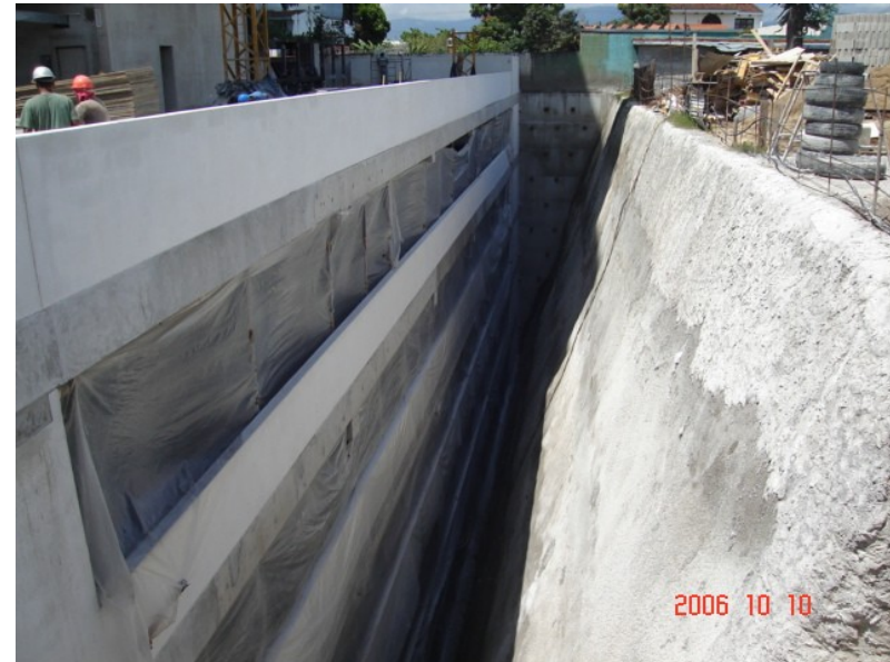
Ilustración 41: Sótanos del edificio de oficinas "Tetra 2"
