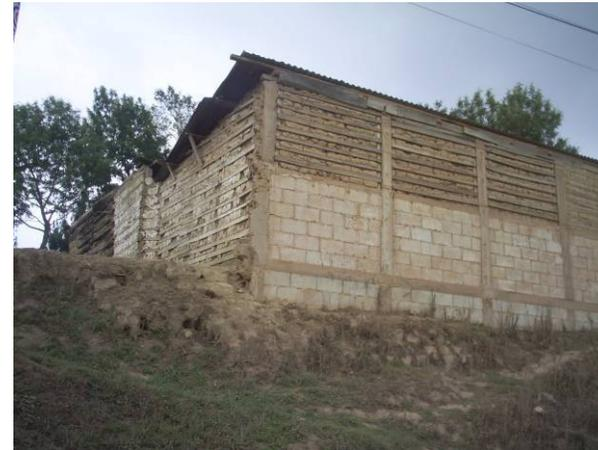
**Foto 39:** Utilización de bajareque donde se observa ya la introducción de bloca y sistemas de soleras y columnas de concreto.
