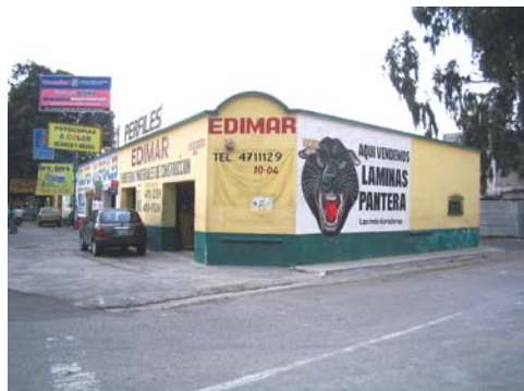
FOTOGRAFIA No. 7 ESQUINA CALZADA AGUILAR BATRES Y 10 CALLE
