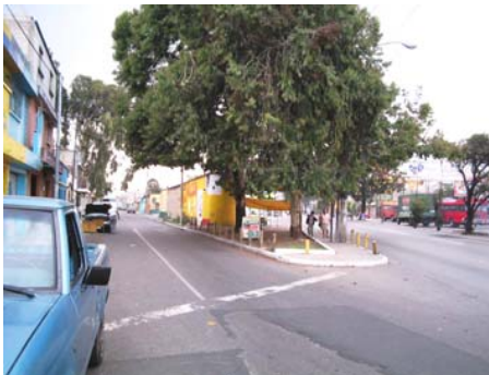
FOTOGRAFIA No. 4 ESQUINA ENTRE 3ª AVENIDA Y CALZADA AGUILAR BATRES HACIA 10 CALLE
