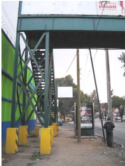
FOTOGRAFIA No. 3 PASARELA CALZADA AGUILAR BATRES, ENTRE 11 Y 10 CALLE
