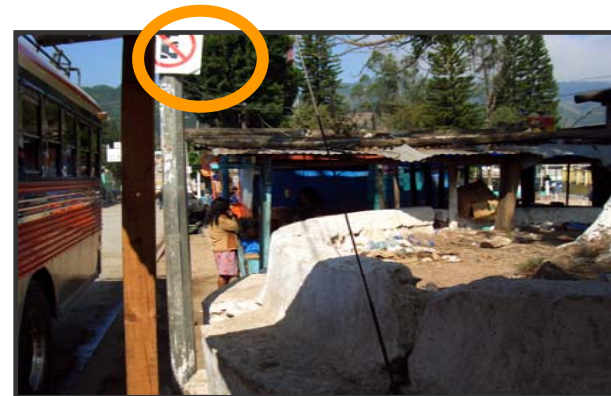
Fotografía 6. Señalización colocada por la Municipalidad, prohibiendo el estacionamiento.
