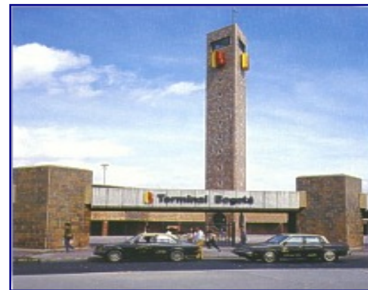
Fotografía 12. Plaza de ingreso y fachada principal de la Terminal de Bogotá
