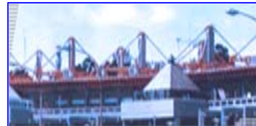
Fotografía 13. Fachada principal de la Estación Terminal de Córdoba
