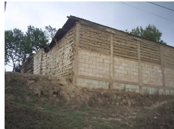
Foto 30. Utilización de bajareque donde se observa ya la introducción de block y sistemas de soleras y columnas de concreto.
