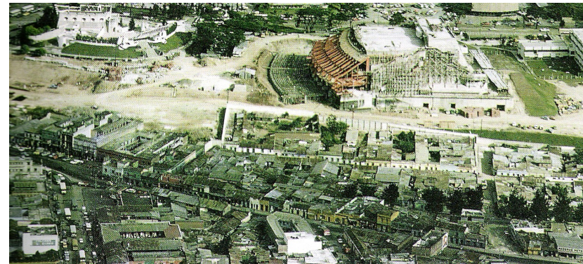
La fotografía muestra cuando se construía el Teatro Nacional en la década del año 1970, y se observa el eje vial de la Avenida Bolívar
