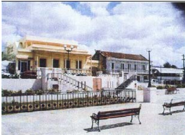
Restauración Casa Blanca o Bernier y Plazoleta Comercial para Restaurante y Galería- Esta esquina está en uno de los lugares más visibles y privilegiados frente a la Plaza, en la calle Quintón
