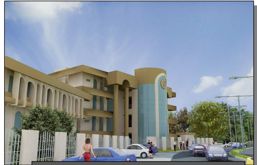
VISTA FRONTAL DERECHA A NIVEL DE BANQUETA
