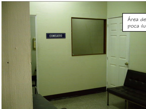
Sala Regional Mixta de la Corte de Apelaciones de Zacapa FOTOGRAFÍA 6 Fuente Propia
