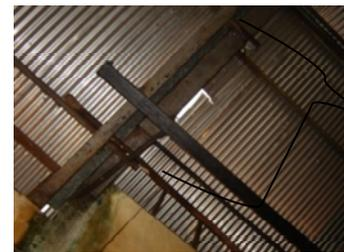
Lámina desgastada con goteras y su estructura se ve insegura.
