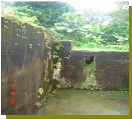
Foto 25 Vista del estado actual de la cimentación del funicular. Elaboración propia.
