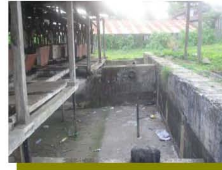
Foto 33 Piletas de recepción de café, bajo área de carritos. El piso es de torta de concreto. Elaboración propia
