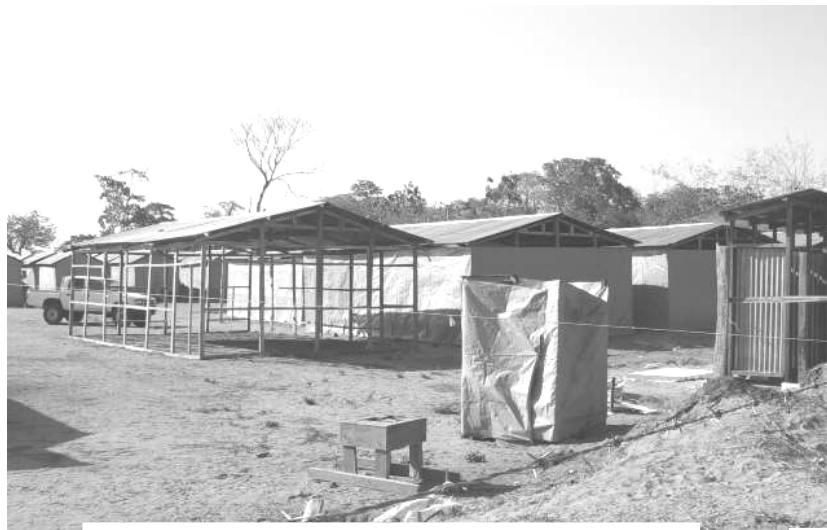
Fotografía 1.8 Estado actual de albergues
