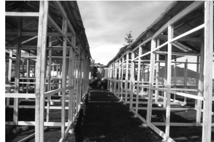
Fotografía de Instalación de Albergues
