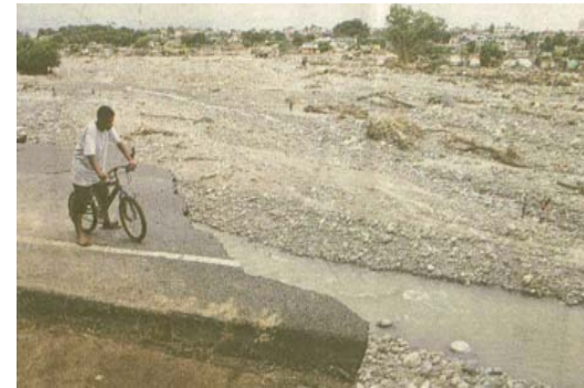
Foto No. 44 Destrozos de la Tormenta Tropical Stan
