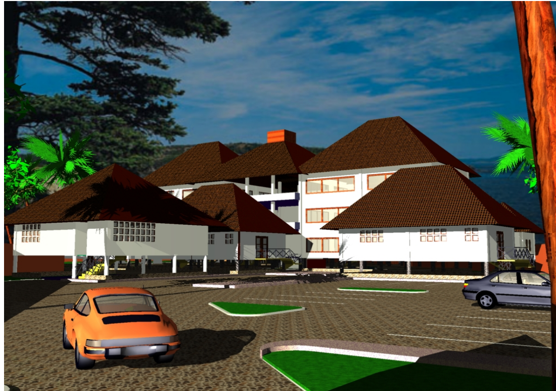
APUNTE DE INGRESO EXTERIOR: DEL ÁREA DE PARQUEO, TALLER MECÁNICO, BODEGAS Y EDIFICIO INTERINSTITUCIONAL
