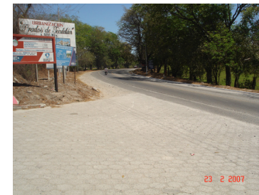
FOTO 2: OBSERVAMOS LA CARRETERA CA-9 HACIA PUERTO BARRIOS.
