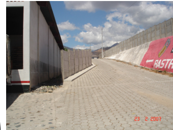
FOTO 3: OBSERVAMOS EL INGRESO VEHICULAR Y EL PEATONAL POR AMBOS LADOS.
