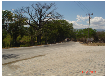
FOTO 1: OBSERVAMOS LA CARRETERA CA-9 QUE VIENE DE GUATEMALA LA CUAL ESTÁ ASFALTADA.
