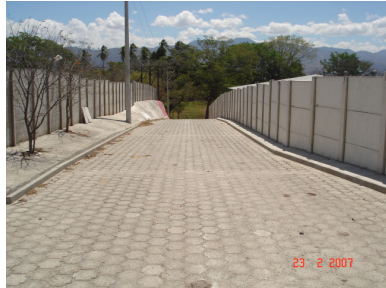
FOTO 4: OBSERVAMOS EL INGRESO DESDE LA GARITA Y ESTA COMPLETAMENTE ADOQUINADO.
