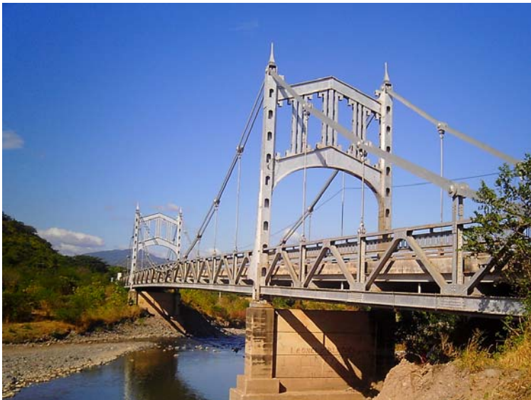
2.1.7 fotografía No. 8 Puente Tamasulapa
