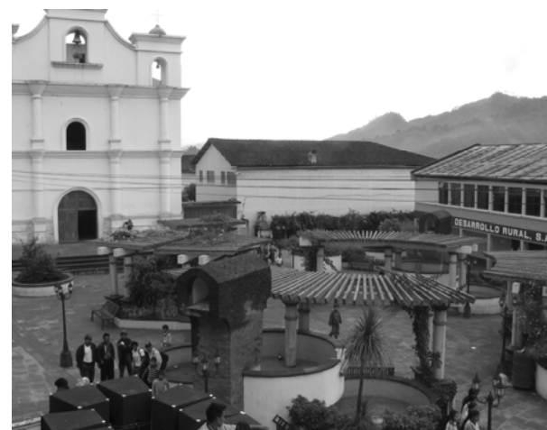
Edificio Municipal Foto: R.M.
