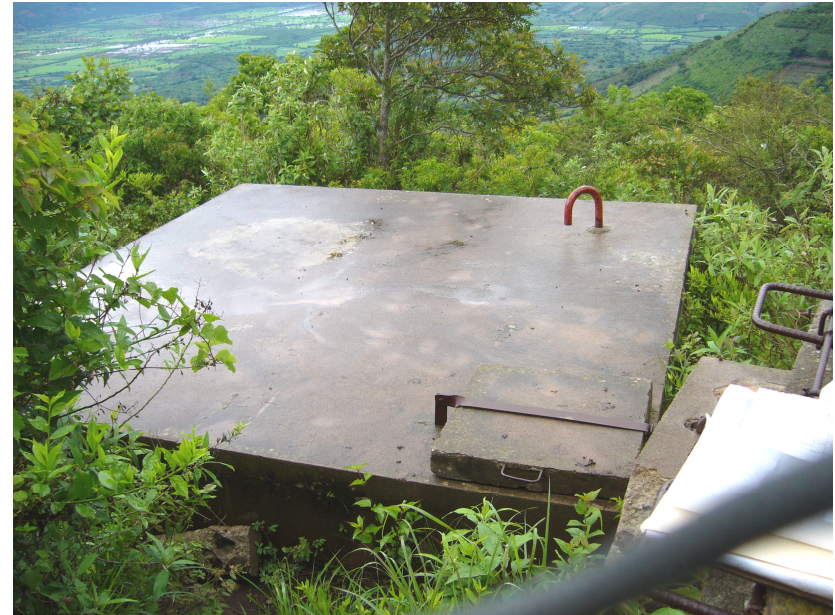
Foto No.4 Tanque de Captación de 50 Mts cúbicos En la aldea Monterrico en el volcán de Monterrico, Agua Blanca, Jutiapa
