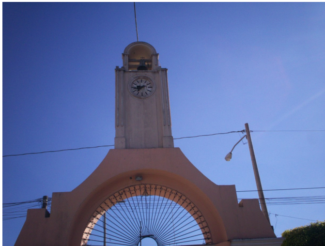
Fotografía nº. 1 Arco de Ingreso a la Municipalidad
