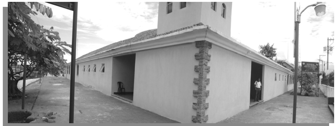
FACHADA NORTE Y OESTE
