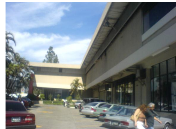
Vista de la fachada sur del edificio.
