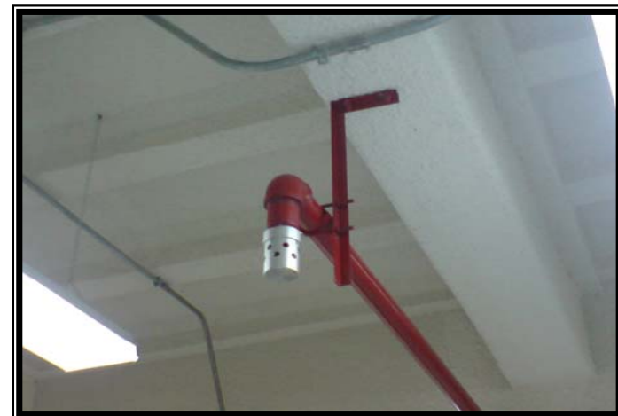
Uno de los agentes extintores para fuego tipo “C” es el agente extintor FM200.
