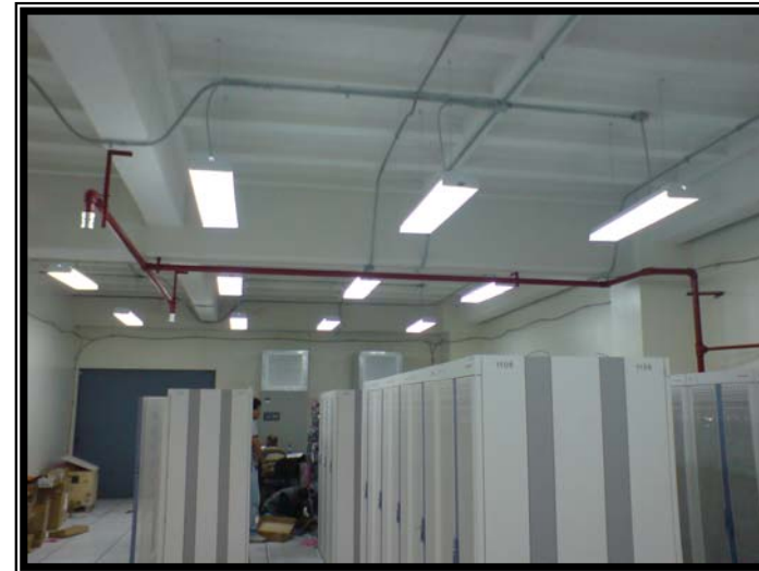
Uno de los agentes extintores para fuego tipo “C” es el agente extintor FM200.
