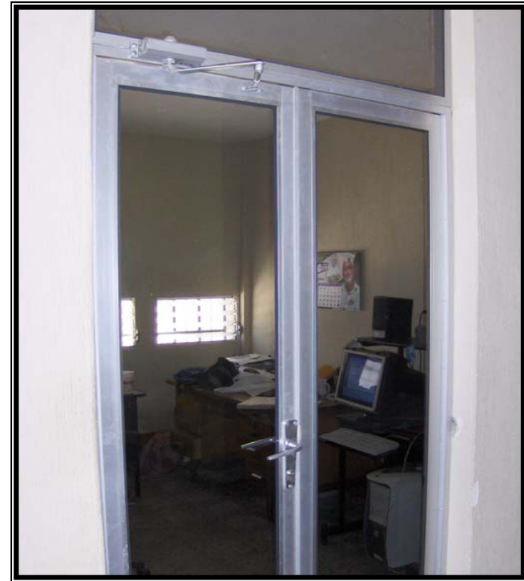
Puerta con dispositivo de cierre propio.
