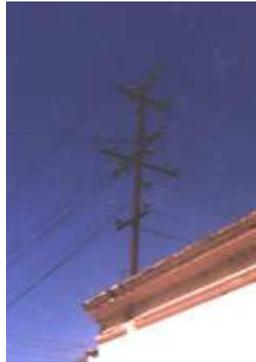
**Fotografía 12.** Utilización de estructuras de Ferrocarril en posteo eléctrico.
