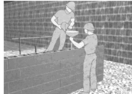
**Figura 75.** Inyección de celdas con embudo
