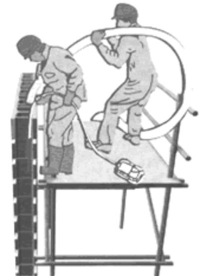
**Figura 76.** Inyección de las celdas con bomba
