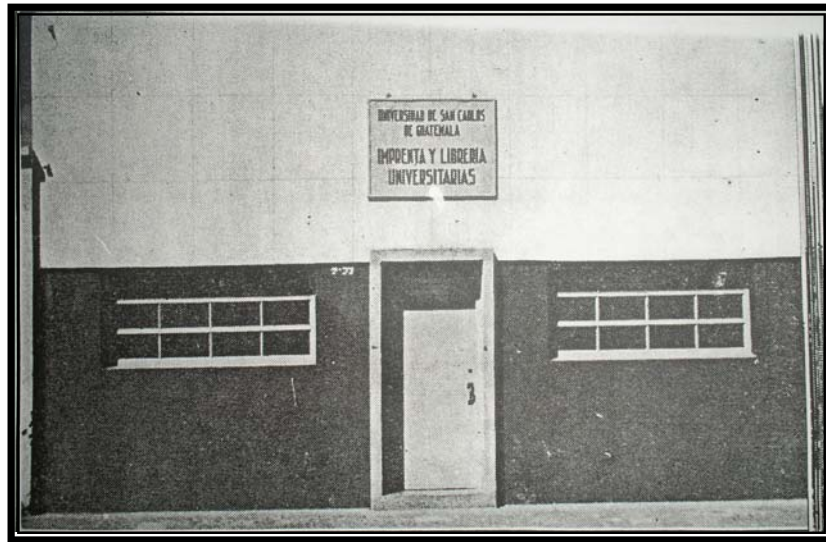
Fachada del nuevo local construido para la Imprenta Universitaria en el predio de la 10ª. Calle Oriente, Año 1951 27
