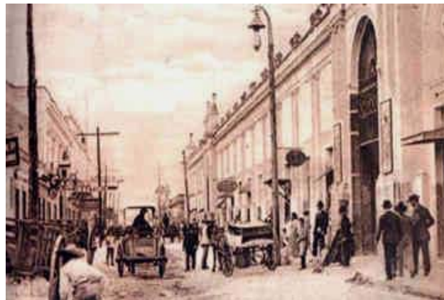
Calle del Mercado Central a la Plaza Central - 1880
