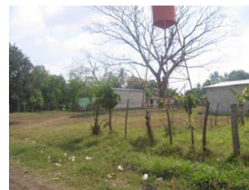
Imagen No 11 Tanque de agua suministro de agua lotificación
