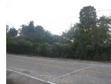
Imagen No 18 El acceso al terreno, por medio de la Ruta Departamental RD-11 el tramo donde se ubica el terreno se encuentra recientemente adoquinado
