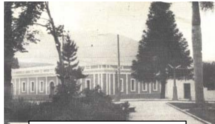
Fotografía No. 52: * Bloque No.7: antigua Escuela No.1.
