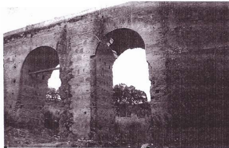
VISTA ACTUAL DESDE EL PONIENTE, NÓTESE EL SISTEMA CONSTRUCTIVO TIPO “CALICANTO” MASIVO DE SUS BASES, LA GRAN ALTURA CUBIERTA, Y LOS DOS ARCOS DE BÓVEDA DE LADRILLO TIPO ELIPSOIDE.
