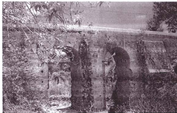
VISTA ACTUAL DESDE EL NORTE VEÁSE LA ALTURA CUBIERTA Y LOS CONTRAFUERTES MASIVOS
