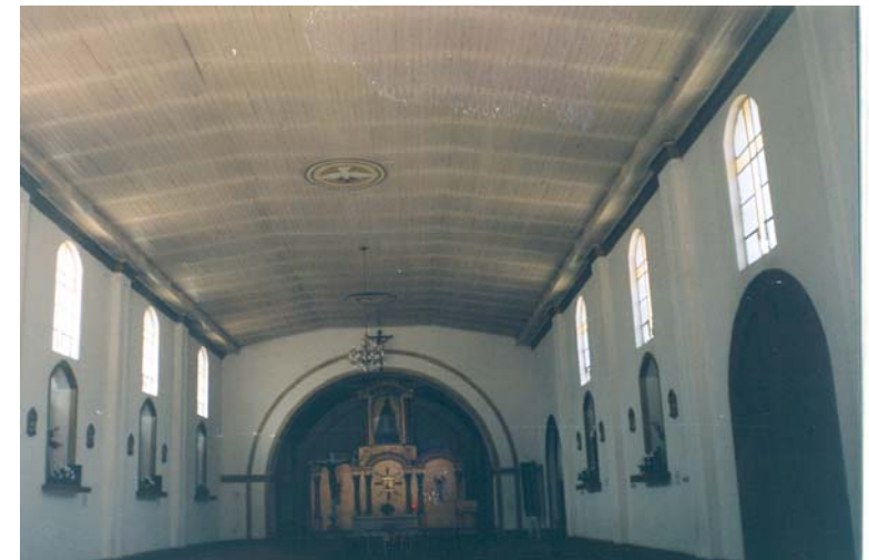
FOTOGRAFIA No. 26: VISTA INTERIOR ACTUAL DE SU UNICA NAVE, DESDE EL INGRESO HACIA EL ALTAR, FUERON EFECTUADAS ALTERACIONES EN SUS PAREDES LATERALES, NOTESE EL CIELO FALSO TIPO “ABOVEDADO” DE MACHIMBRE.
