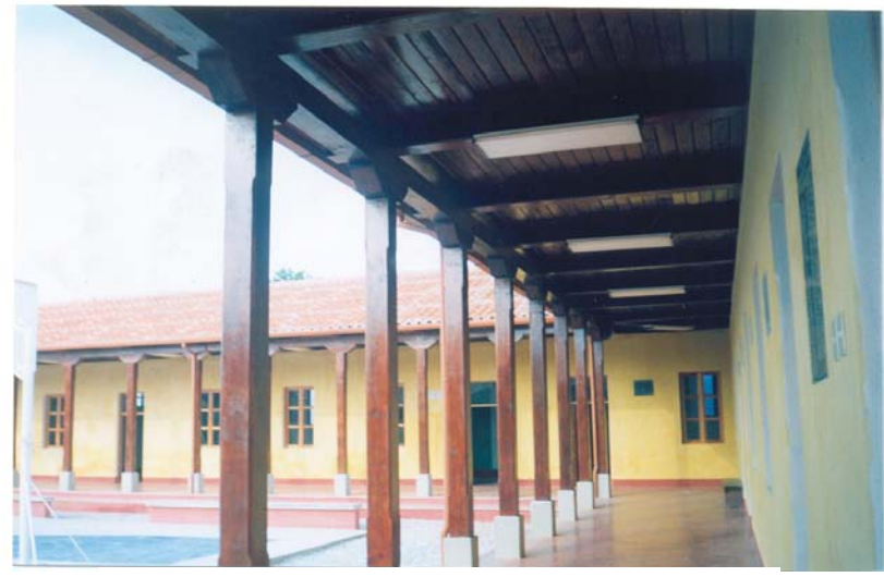
FOTOGRAFÍA No. 38: VISTA ACTUAL DEL INTERIOR, NOTESE EL INTERCOLUMNIO
