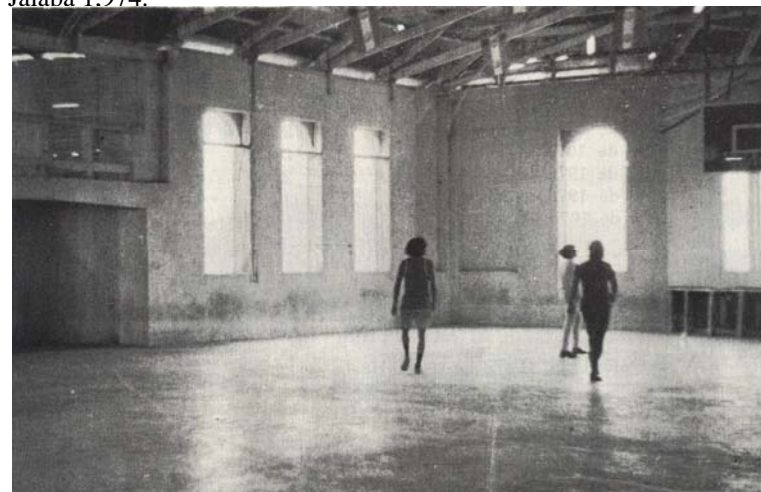
DERECHA: VISTA INTERIOR DESDE EL SUR AÑO 1,974 NÓTESE LA GRAN LUZ DE LA ARMADURA DE MADERA DEL TECHADO
