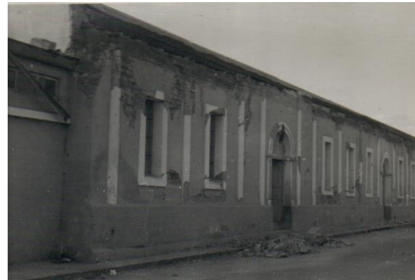
FOTOGRAFÍA No.53: ELEVACION NORTE ORIGINAL PREVIO A SU DEMOLICIÓN
