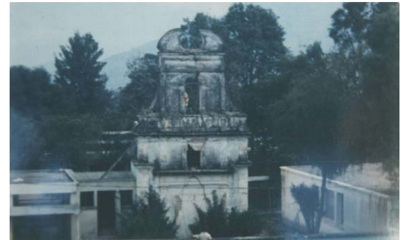
FOTOGRAFIA No. 29: PORTADA ORIGINAL PREVIO A SU DEMOLICIÓN AÑO 1,980
