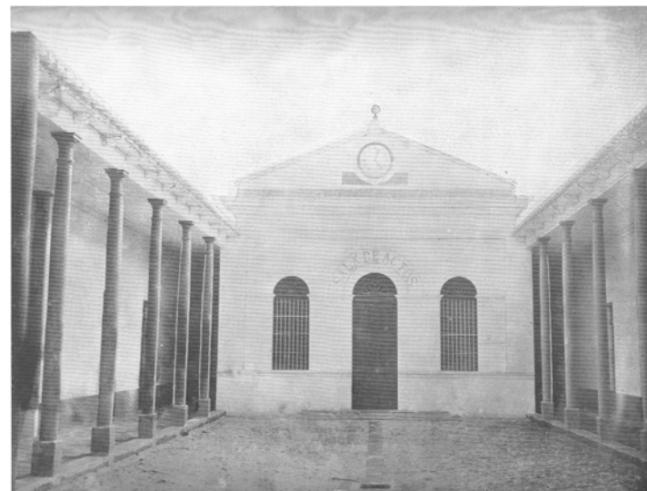
FOTOGRAFÍA No. 42: VISTA INTERIOR DISEÑO ORIGINAL
