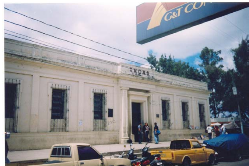
FOTOGRAFÍA No. 43: ELEVACIÓN ACTUAL, NOTESE EL ESCUDO Y LA BARRA PERIMETRAL CON REJA QUE YA NO FUERON RECONSTRUIDOS
