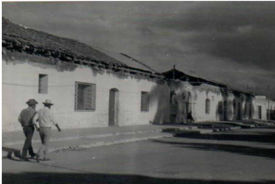
VISTA EXTERIOR DESDE EL ORIENTE DEL MONUMENTO DEMOLIDO, AÑO 1976 DE L CUAL SOLO QUEDARON LAS PAREDES DEL PRESIDIO Y PNC AL CENTRO
