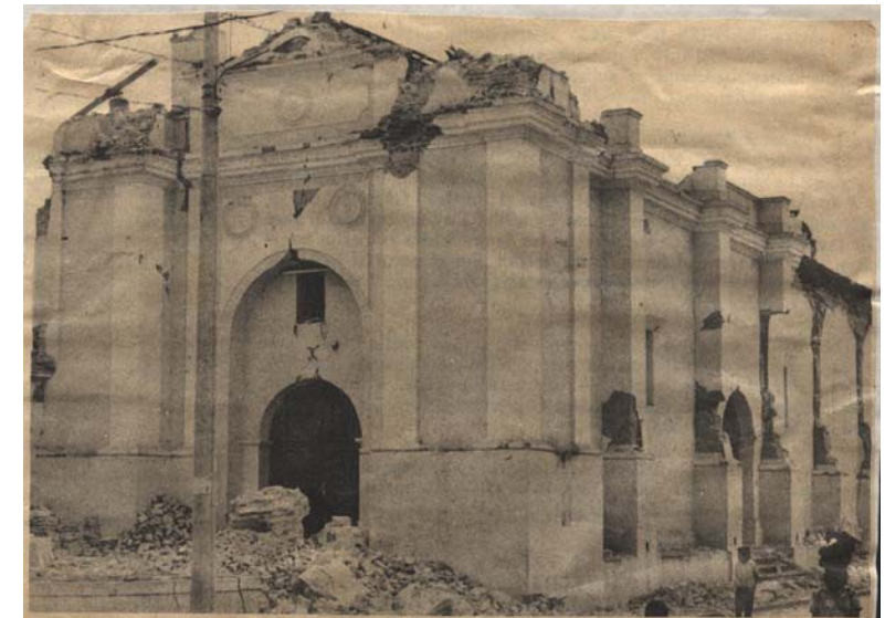
FOTOGRAFIA No. 25: VISTA EXTERIOR CON LOS DAÑOS DEL TERREMOTO DE 1,976 POSTERIORMENTE CONSERVANDO SU PORTADA, EL ALTAR Y SU CUPULA EN LA PARTE POSTERIOR. FUE RECONSTRUIDO EL CUERPO SUPERIOR DEL FRENTE Y SUS PAREDES LATERALES
