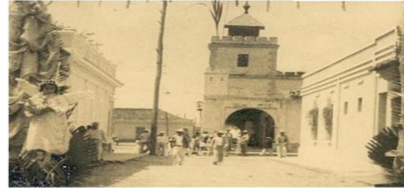
FOTOGRAFÍA No. 132: Fuente: Irma Polanco Estrada.
