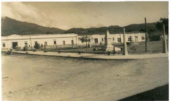
FOTOGRAFÍA No. 137: Fuente: Irma Polanco Estrada
