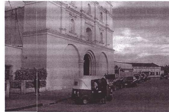
FOTOGRAFIA No. 19: ENTORNO ACTUAL DE LA CATEDRAL, A LA IZQUIERDA LA CASA PARROQUIAL, A LA DERECHA EL OBISPADO Y ENFRENTA EL TRAFICO VEHICULAR DEL PARQUE.
