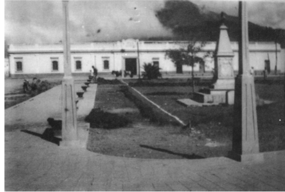
FOTOGRAFÍA No.63: Fuente: Irma Polanco Estrada.
