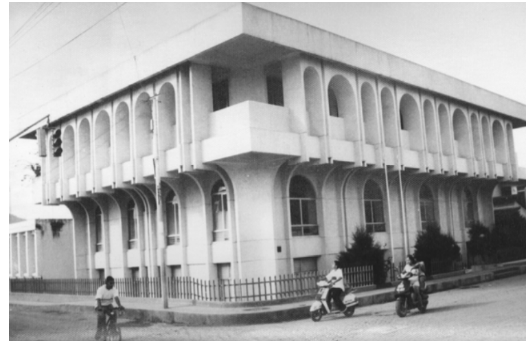
VISTA EXTERIOR DEL ACTUAL NUEVO EDIFICIO, AÑO 2,005
