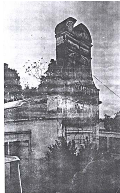
FOTOGRAFIA No. 31: PORTADA ORIGINAL PREVIO A SU DEMOLICIÓN
