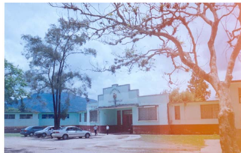
FOTOGRAFÍA No. 46: VISTA EXTERIOR ACTUAL DESDE EL PONIENTE, NOTESE QUE EL DISEÑO ORIGINAL SE CONSERVA, SOLO PRESENTA DETERIOROS.
