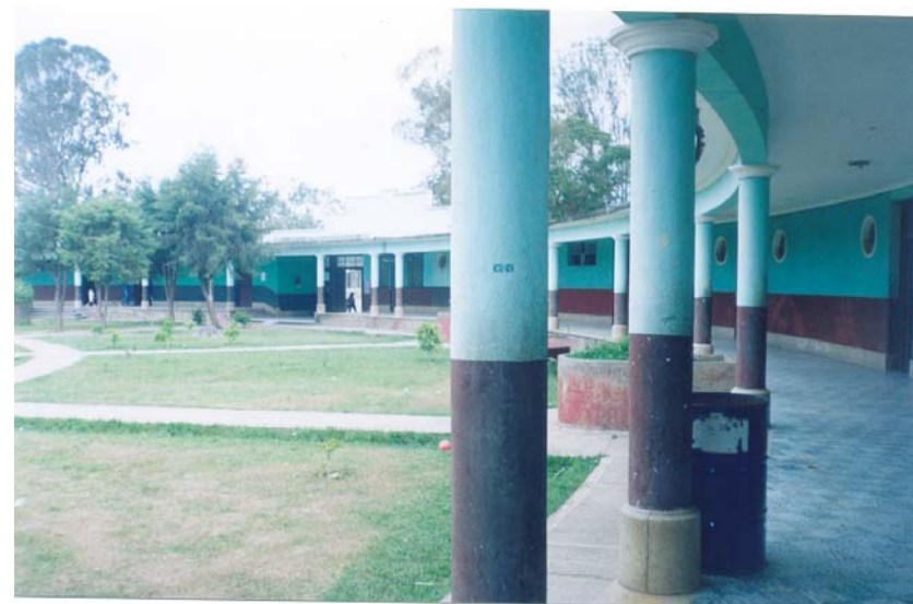
FOTOGRAFIA No.47: VISTA INTERIOR DESDE EL NORTE HACIA EL INGRESO PRINCIPAL, NOTESE EL ORIGINAL DISEÑO CIRCULAR
