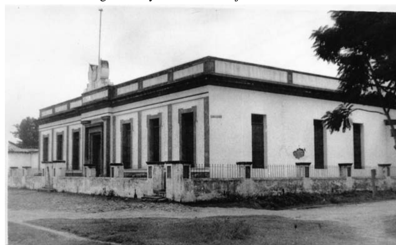
FOTOGRAFIA No.41: ELEVACIÓN ORIGINAL DESDE EL NORTE, POSIBLEMENTE 1,940 AÚN CON SU ESCUDO Y BARDA PERIMETRAL
