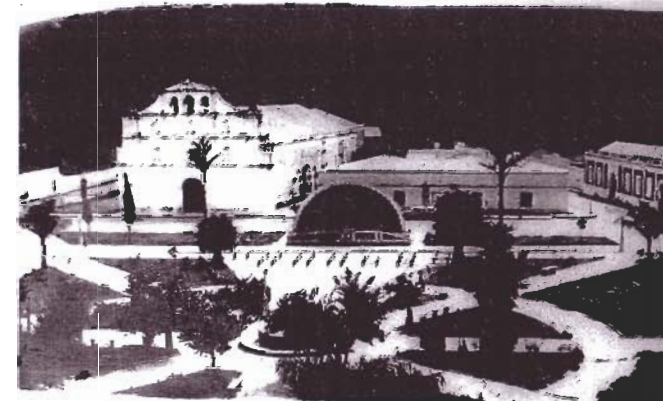
FOTOGRAFIA No.16: ENTORNO ORIGINAL DESDE EL PONIENTE, POSIBLEMENTE AÑO 1,960.
