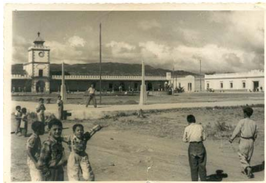
FOTOGRAFÍA No. 145: Fuente: Irma Polanco Estrada.
