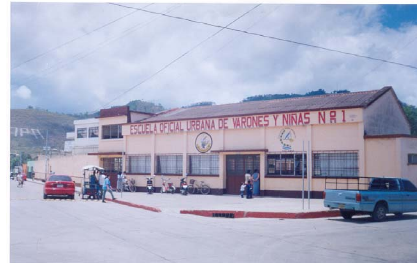
FOTOGRAFÍA No.54: VISTA EXTERIOR DEL NUEVO EDIFICIO.
