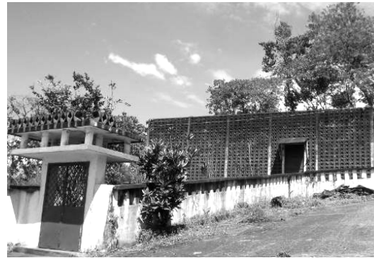
Foto No.37 Casa peatonal
