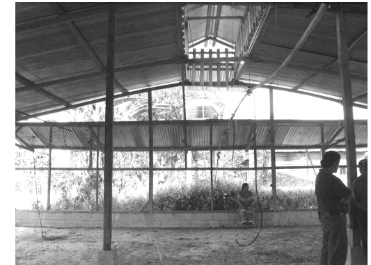
Foto No.44 Bodegas multiusos.
