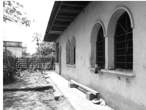
Foto No.39 Edificio de Oficinas
