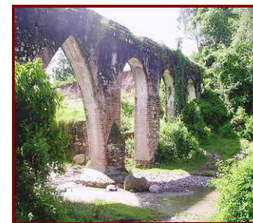
Fotos No. 22: Acueductos los Arcos
