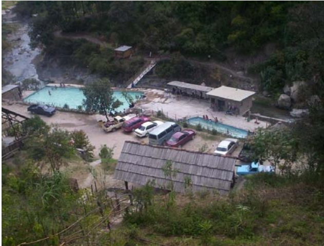
Foto No. 1 Vista aérea
