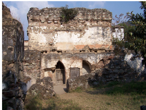
Fotografía No. 14 Ingreso a la sacristía del Templo
