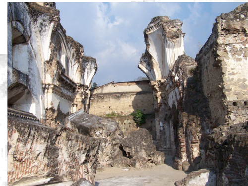
Fotografía No. 10 Interioro del Templo, aquí se puede observar el estado actual del Templo
