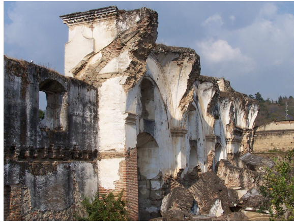
Fotografía No. 12 Vista del techo de Templo
