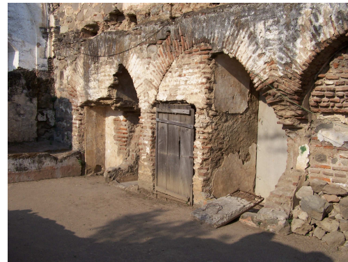
Fotografía No. 15 Ingreso a la Sacristía del Templo
