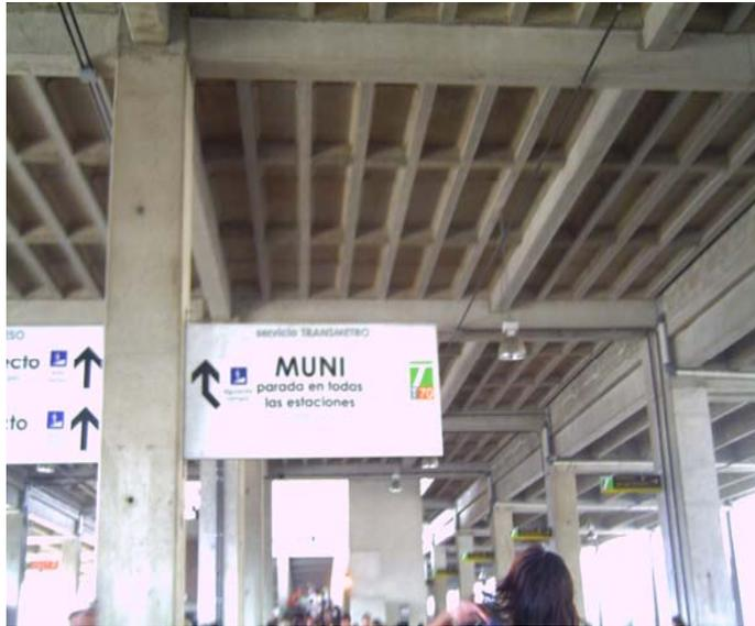
Debido al acondicionamiento climático tanto de transportistas y usuarios el área de abordaje de buses es techada, utilizando estructuralmente moldes LK, rigidizantes, viguetas y vigas fundidas en concreto, que son las que dan un reforzamiento adecuado al tipo de solución estructural vertical (columnas) y al mismo tiempo sirviendo como decoración reticulada y articulada en el cerramiento horizontal.
