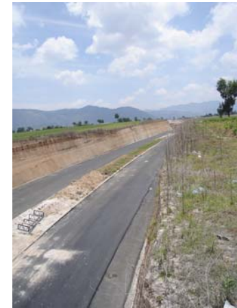
IMAGEN 39: NUEVA CARRETERA INTERAMERICANA C-1
