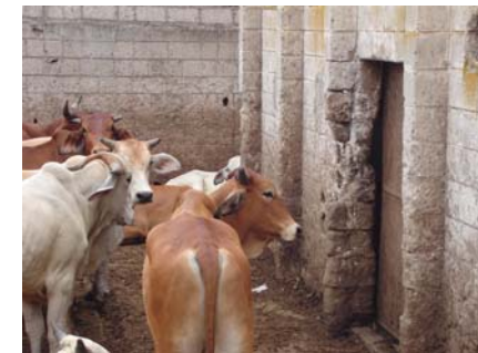
IMAGEN 26: Infraestructura en deterioro y abandono
