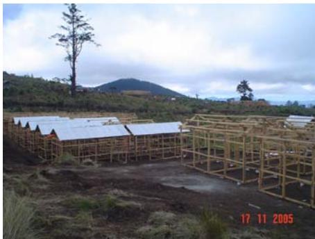
Foto No. 14 Módulos de Albergues unifamiliares temporales
