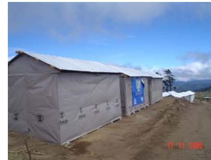
Foto No. 15 Módulos de Albergues unifamiliares temporales
