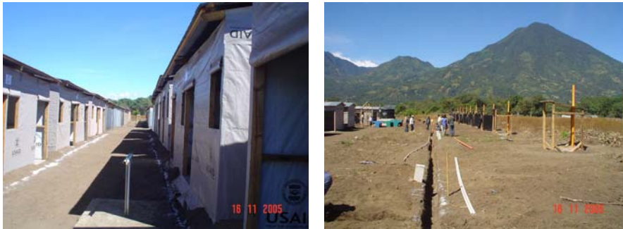
Foto No. 13 Módulos de Albergues unifamiliares temporales
