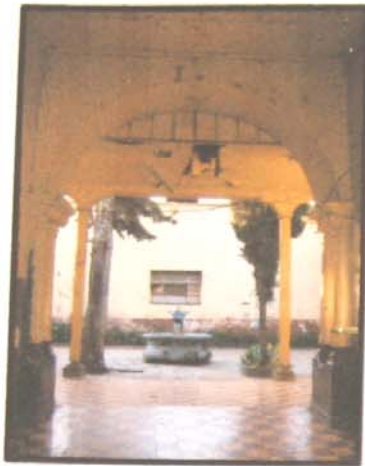
FOTO No. 18 Vista de vestíbulo Principal Ingreso Antigo Hospital Nacional de Huehuetenango
