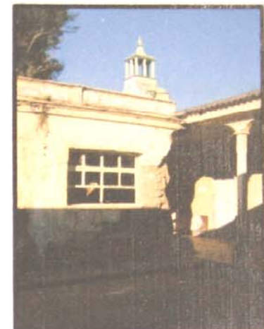
FOTO No. 21 Detalle de Corredores Ala Este Antigo Hospital Nacional de Huehuetenango
