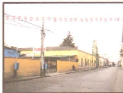
FOTO No.2 Fachada Principal Ala ESTE sobre 6a. calle observese mobiliario urbano e infraestructura urbana Antiguo Hospital Nacional de Huehuetenango
