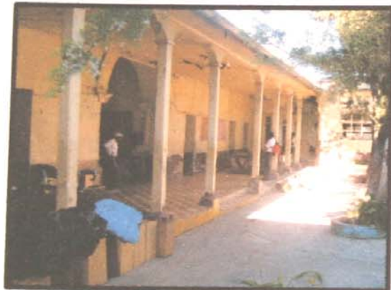
FOTO No. 22 Corredor Principal de Ingreso Interior patio central Antigo Hospital Nacional de Huehuetenango
