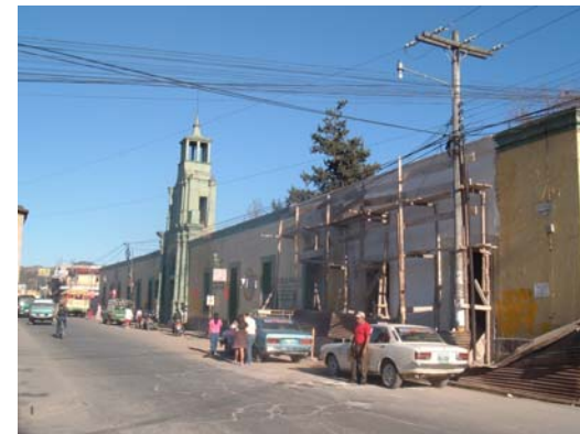
Fachada Principal ANTIGUO HOSPITAL NACIONAL Sobre la 6ta calle
