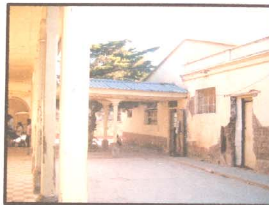
FOTO No. 23 Comunicacion entre Corredor Ala Este y Area Central Antigo Hospital Nacional de Huehuetenango
