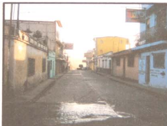
FOTO No.16 Viviendas dentro del entorno urbano inmediato rompen con el equilibrio de las edificaciones antiguas, en proporción y forma Antiquo Hospital Nacional de Huehuetenango
