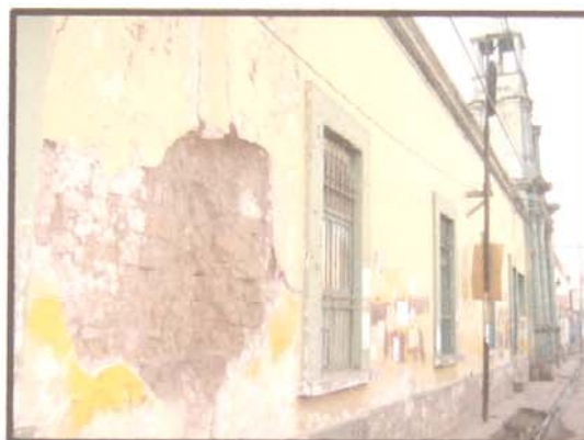
FOTO No.13 Evidencias de causas intrínsecas provocadas por el paso del tiempo Daños físicos Fachada Principal Antiquo Hospital Nacional de Huehuetenango
