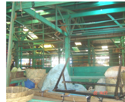
Foto 2.6.3.- 4: Infraestructura con la que se cuenta actualmente. Foto: Regina Barrios.
