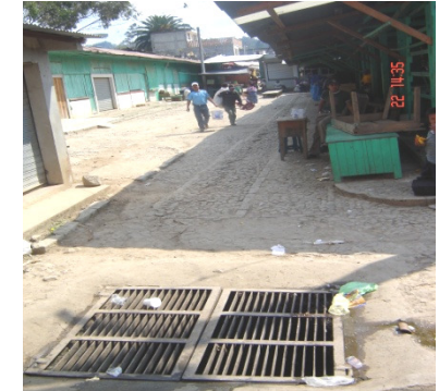
Foto 2.6.3.- 2: Drenajes expuestos, foco de contaminación directo. Foto: Regina Barrios.
