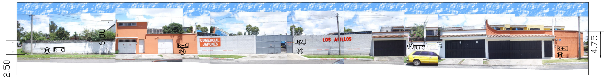
PERFIL DE LA 20 CALLE DESDE LA 7ª AVENIDA HACIA LA 6ª AVENIDA.
