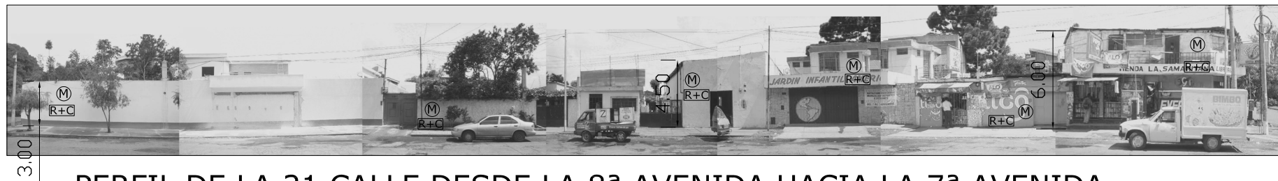
PERFIL DE LA 21 CALLE DESDE LA 8ª AVENIDA HACIA LA 7ª AVENIDA.
