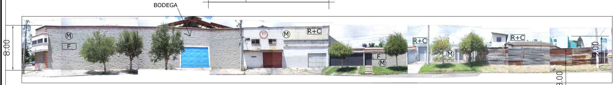
Perfil de la 6ª avenida desde la 21 calle hacia la 20 calle.
