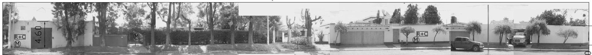
PERFIL DE LA 8ª AVENIDA DESDE LA 20 CALLE HACIA LA 21 CALLE.
