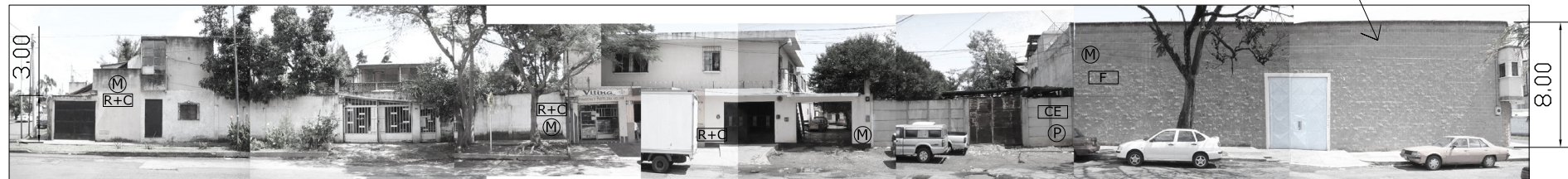
PERFIL DE LA 21 CALLE DESDE LA 7ª AVENIDA HACIA LA 6ª AVENIDA.
