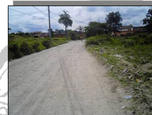
ACCESO DE TERRACERÍA
