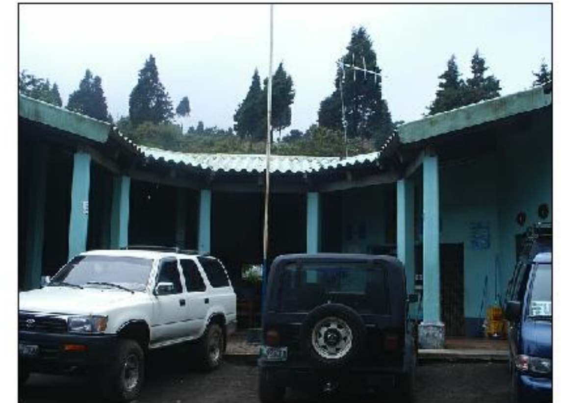
Vista frontal de centro de visitantes actual.
