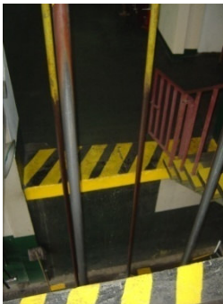
Vista No. 22 - Foto No. 86 Tubos de descenso corroídos y sin aparente mantenimiento. (Elaboración propia, 2007)
