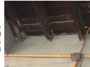
Vista No. 6 - Foto No. 70 Entrepiso de madera de más de 30 años el cual está en un estado de putrefacción al punto del colapso (Elaboración propia, 2007)
