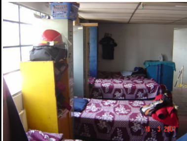
Vista No. 91 - Foto No. 156 La altura actual del dormitorio es demasiado baja lo que provoca calor a toda hora del día. (Elaboración propia, 2007)
