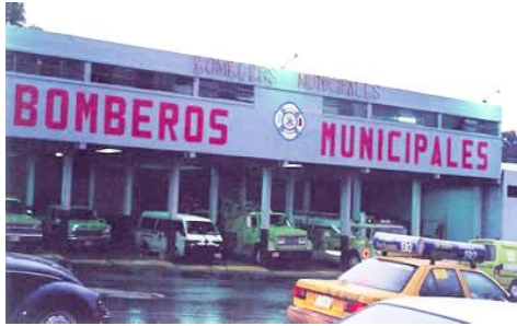
Foto No. 11. Estación Central del Benemérito Cuerpo de Bomberos Municipales zona 02. (Recuperado el 27 de julio de 2007, de http://www.cbm123.com/inicio/historia.htm )
