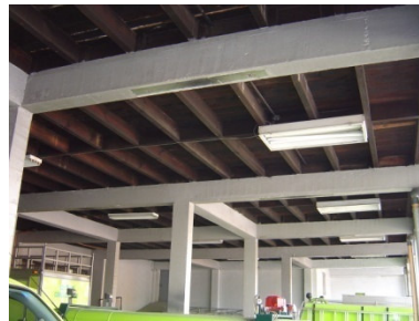
Vista No. 10 - Foto No. 74 Entrepiso en mal estado y lámparas quemadas y quebradas completamente deterioradas. (Elaboración propia, 2007)
