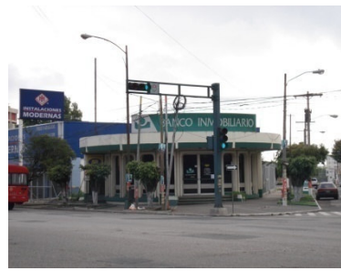
Vista No. 116 - Foto No. 183 Banco Inmobiliario intersección de la 7 avenida y vía 7 zona 4 (Elaboración propia, 2007)
