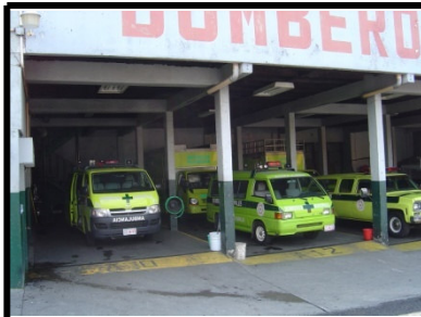
Vista No. 1 - Foto No. 65 Ingreso a la estación sin ningún tipo de protección al frente. (Elaboración propia, 2007)
