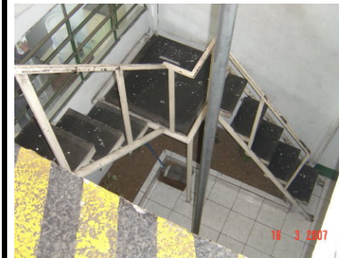
Vista No. 95 - Foto No. 160 Área de gradas y tubo insuficientes para una situación de emergencia (Elaboración propia, 2007)
