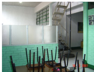
Vista No. 72 - Foto No.138 Problema de circulación cruzada ya que esta próxima al área del tubo de descenso. (Elaboración propia, 2007)
