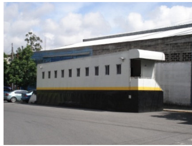
Vista No. 60 - Foto No. 126 2 Calle frente a la estación de Bomberos zona 2 Serenazgo Policía Nacional. (Elaboración propia, 2007)
