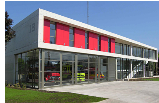
Foto No. 62. Estación del Cuerpo de Bomberos de Santiago, Chile vista de día. (Recuperado el 18 de agosto de 2007, de www.revistaca.cl/.../2007/07/130_p_bomberos.jpg ).
