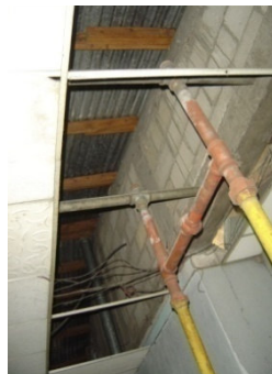
Vista No. 22 - Foto No. 86 Tubos de descenso corroídos y sin aparente mantenimiento. (Elaboración propia, 2007)
