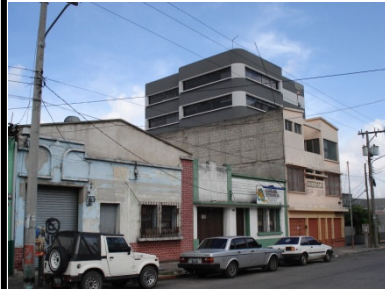
Vista No. 97 - Foto No. 164 Fachadas de la industria de reciclaje y de la empresa CODEMISA sobre la ruta 7 zona 4. (Elaboración propia, 2007)
