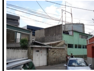
Vista No. 112 - Foto No. 179 Fachada posterior de la 5ta. Estación de bomberos Municipales zona 4 (Elaboración propia, 2007)
