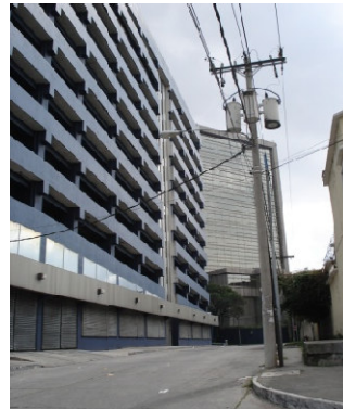
Vista No. 130 - Foto No. 197 Edificio de parqueos de las Torres del Banco industrial, sobre la vía 6 entre la ruta 6 y ruta 7 zona 4 (Elaboración propia, 2007)
