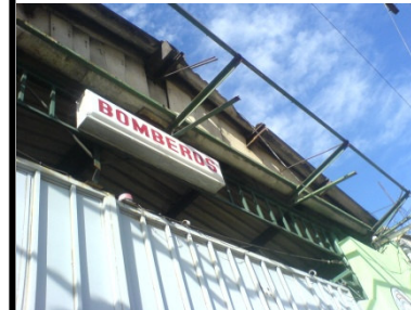
Vista No. 83 - Foto No.149 Estructura del techo en mal estado, lámina corroída por el óxido. (Elaboración propia, 2007)
