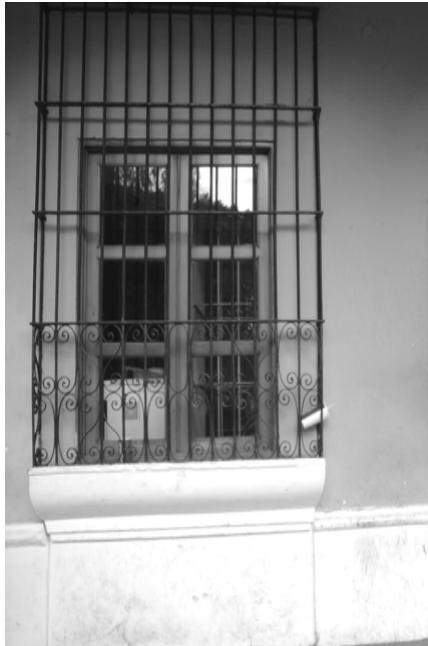
*Vista de ventana con dos hojas marco de madera y vidrio con contraventana de madera, protección, balcón de hierro forjado y repisa con vano normal . . V-1*
