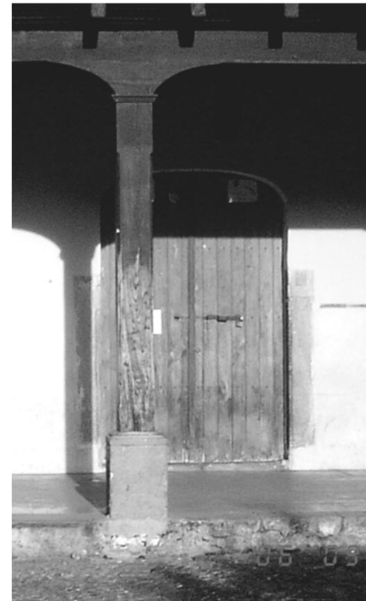
*Vista de puerta de madera a dos hojas, con marco de mampostería y jambas de piedra a los lados, de talle ventanilla de hierro forjado con sobre marco de madera, con arco rebajado de 2.70 de alto por 1.68 de ancho T-2*
