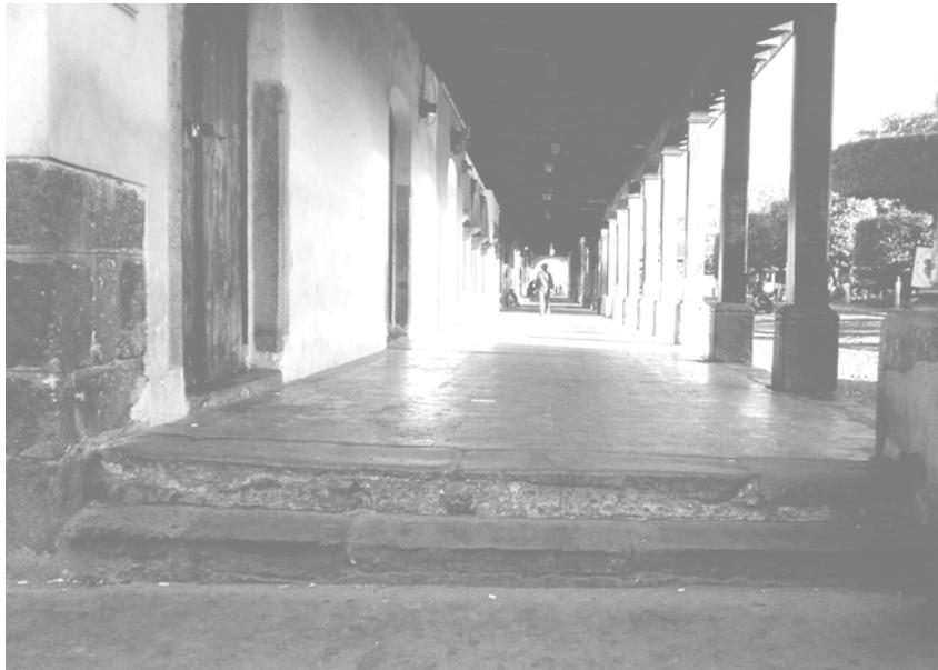
*Vista del piso del portal desde la 5ta calle poniente (se puede observar el empleo de piedra en sus gradas y cemento liquido en esta área del portal.*
