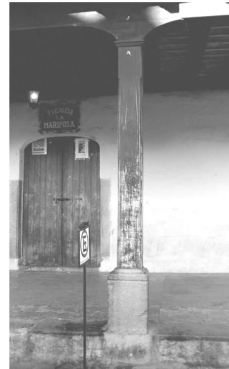
Vista de columna de madera con ochavo, zapata de madera con base de piedra.
