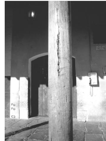
*Vista de columna o fuste deteriorada extrínseco (física y biológico)*
