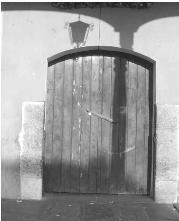
*Vista de puerta de madera teñida a dos hojas, con marco de mampostería y jambas de piedra a los lados, sin detalle., con arco rebajado de 2.31 de alto por 1.64 de ancho. T-5*
