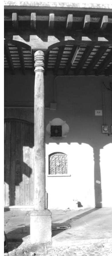
*Vista de columna de madera redonda con zapata de madera y base de piedra
