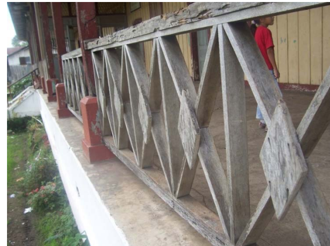
Foto #25. Detalle de baranda en la Administración Fotografía: W. de Paz y A. Pérez
