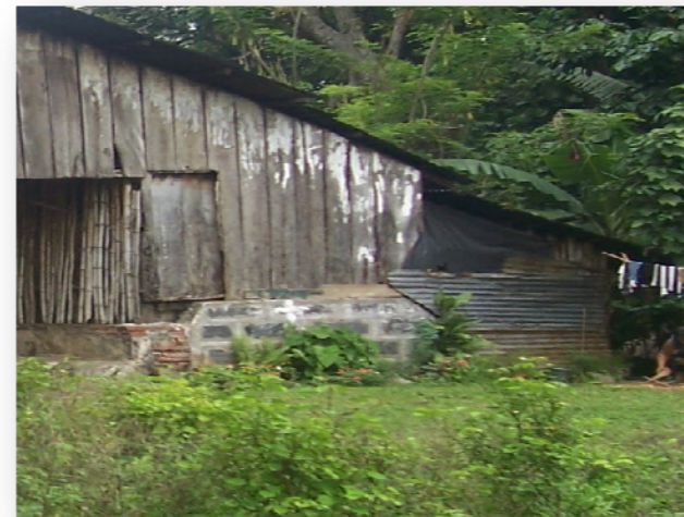
Foto #70. Vista de los muros de la Caballeriza Fotografía: W. de Paz y A. Pérez
