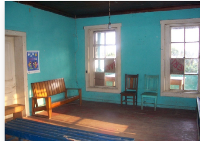
Foto #74. Deterioro en la duela de madera de la Casa Patronal. Fotografía: W. de Paz y A. Pérez
