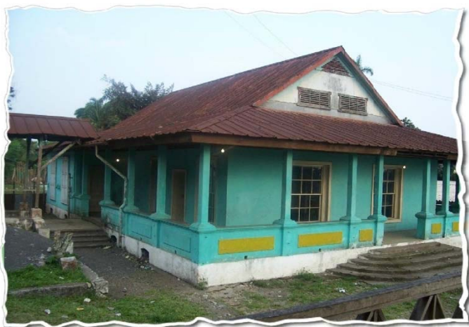
Foto # 5. Casa Patronal. Fue utilizada como casa de habitación, para el administrador de dicha finca, en la actualidad se encuentra en buen estado. Fotografía: W. de Paz y A. Pérez.
