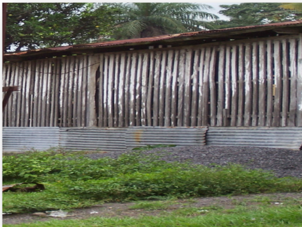
Foto #67. Muros exteriores de madera de la Bodega Fotografía: W. de Paz y A. Pérez
