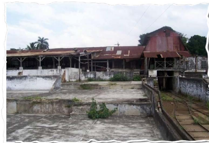
Foto #2. Beneficio húmedo de café. Esta parte del conjunto en la actualidad es utilizada en época de cosecha, pero el deterioro es inminente. Fotografía: W. de Paz y A. Pérez.
