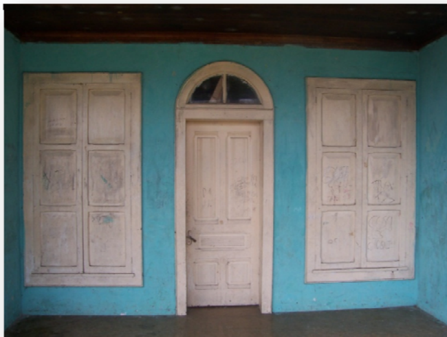
Foto #47. Puertas y ventanas de la Casa Patronal Fotografía: W.de Paz y A. Pérez
