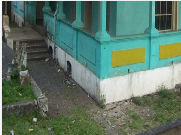
Foto #42. Cimiento de la Casa Patrona del Conjunto Histórico de San Andrés Osuna. Fotografía: W. de Paz y A. Pérez
