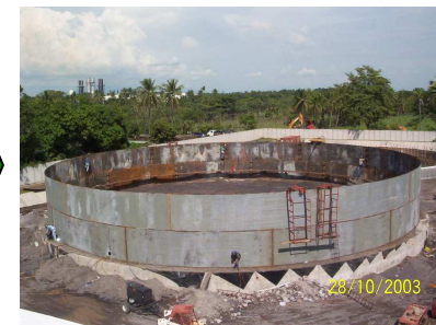
Montaje de piso y paredes.
