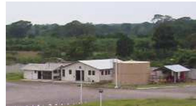
Fotografía No. 29 Vista del área de bodegas y modulo contra incendios. Fuente: Foto Propia.
