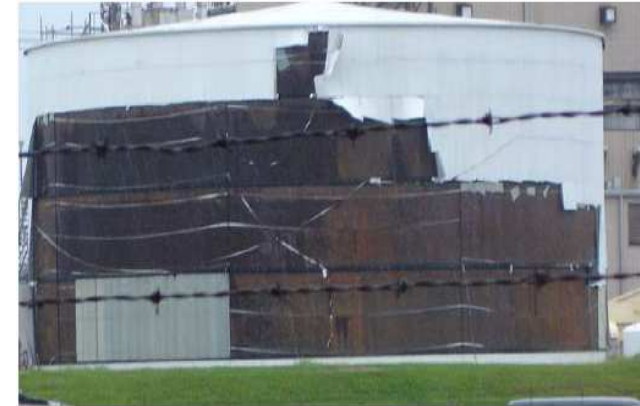
Fotografía No. 10, Planta Invicta, Dupont en Sabine, Texas octubre 2005 /daños a tanque. Fuente: Luis A. Godoy. Universidad de Puerto Rico, misión de reconocimiento. Huracán Rita.
