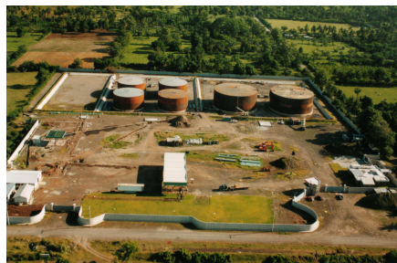
Montaje de los tanques.
