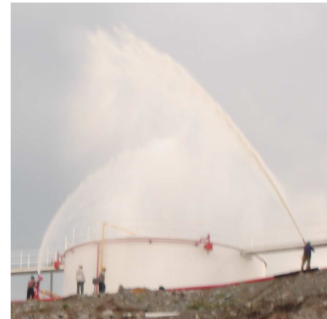
Fotografía No. 26 Simulacro de uso de cañones para enfriamiento de tanque Fuente: Fotografía propia.
