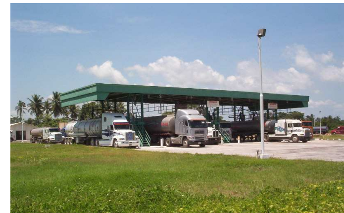
Fotografía No. 22 Rack de distribución operando. Fuente: información terminal. Fotografía propia.
