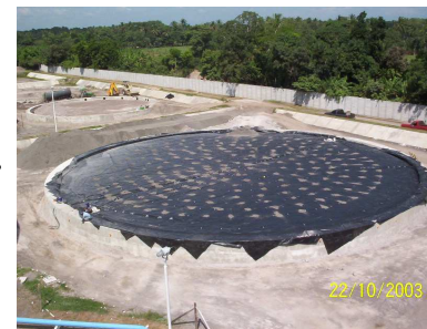
Colocación de impermeabilizante y E instalación de protección catodica
