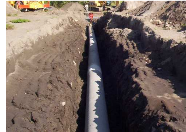
Fotografía No. 6, Oleoducto subterráneo en su fase de montaje. Fuente: fotografía propia, montaje de oleoducto en Puerto Quetzal, Guatemala.2002.
