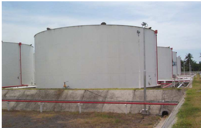
Fotografía No.20 Muestra diques de contención. Fuente: información Terminal. / Fotografía propia.
