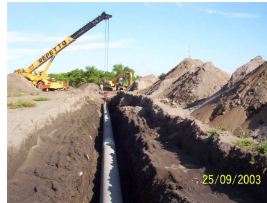
Montaje sistema contra incendios
