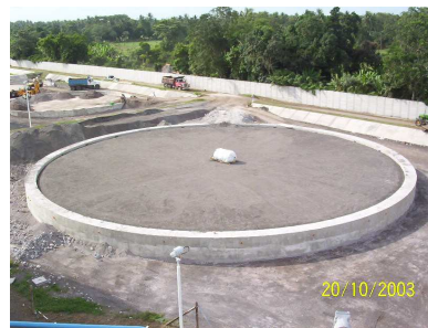
Construcción de cimentación de los tanques y nivelación de fondo.
