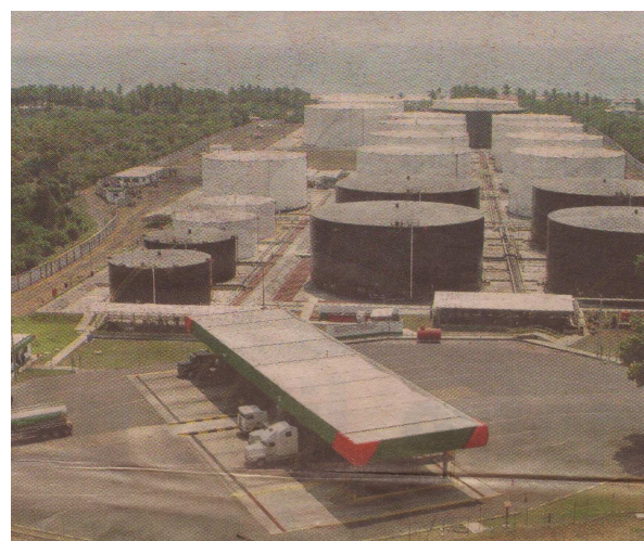
Foto No. 2 Terminal de almacenamiento de combustibles ubicada en la costa del Pacífico de Guatemala.
