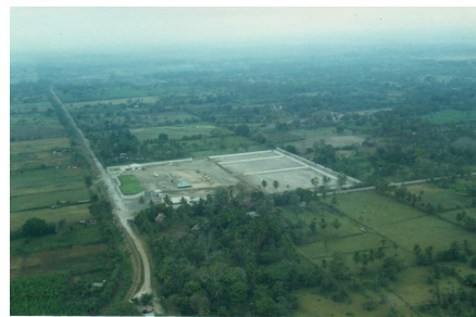
Trabajos preliminares, preparación de terreno y diques de contención
