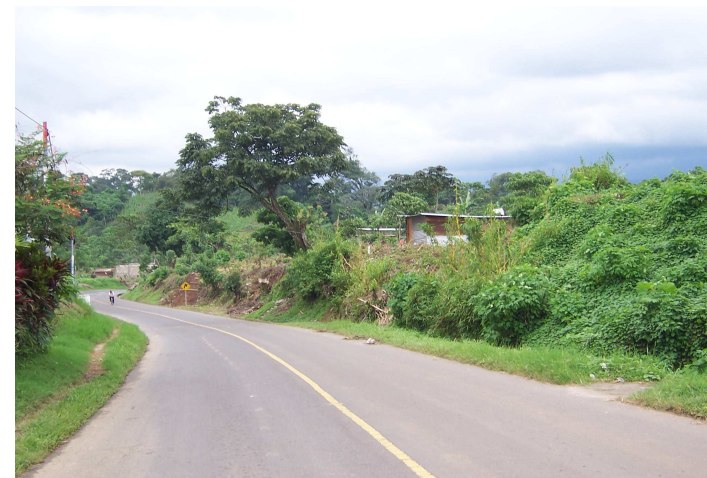
Foto No. 10 Vista Típica de Corredor -Ingreso a la Cabecera Municipal-
