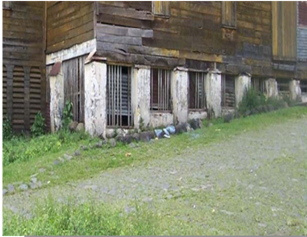
Foto #49. Cimiento de pilotes del Beneficio seco Fotografía: W. de Paz y A. Pérez
