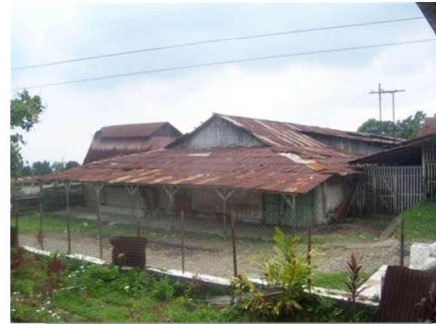
Foto #44. Techo de lámina de zinc recubierto con pintura anticorrosiva roja. Fotografía: W. de Paz y A. Pérez
