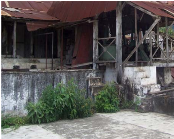
Foto #40. Losa de cimentación Beneficio húmedo con espesor de 1.50 mts. Fotografía: W. de Paz y A. Pérez
