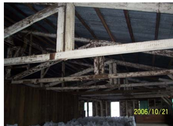
Foto # 53. La estructura del techo de Beneficio seco es de madera y la cubierta de lámina de zinc. Fotografía: W. de Paz
