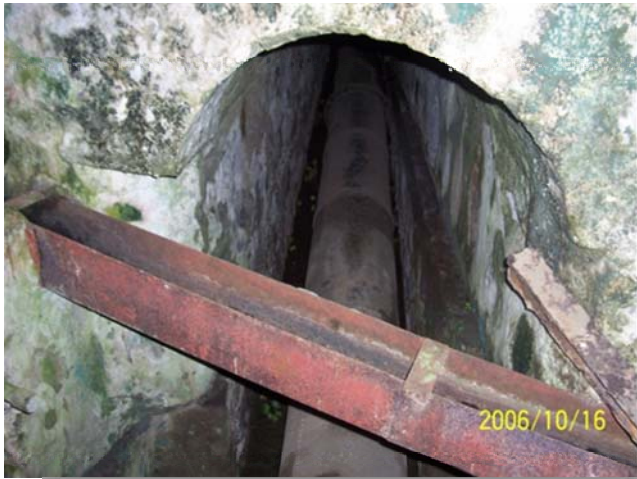
Foto #46. Ducto por el cual es transportada el agua del rio Cucunú hacia el Beneficio de café.
