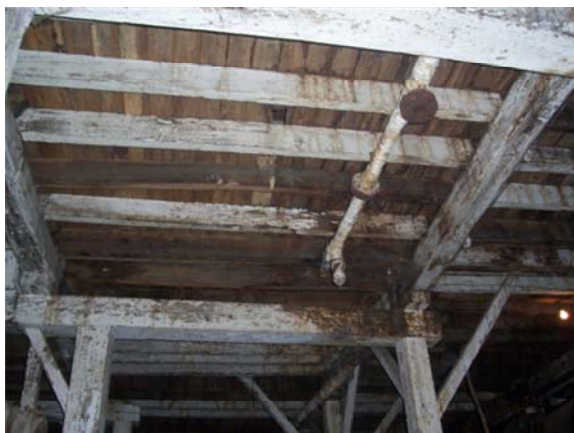
Foto #52. Detalle de entrepiso de madera del edificio del Beneficio seco. Fotografía: W. de Paz y A. Pérez
