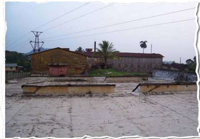
Foto # 3. Beneficio seco de café. Esta parte del beneficio esta construido casi en su totalidad con madera y por el paso del tiempo y el descuido se encuentra muy deteriorado. Fotografía: W. de Paz y A. Pérez.
