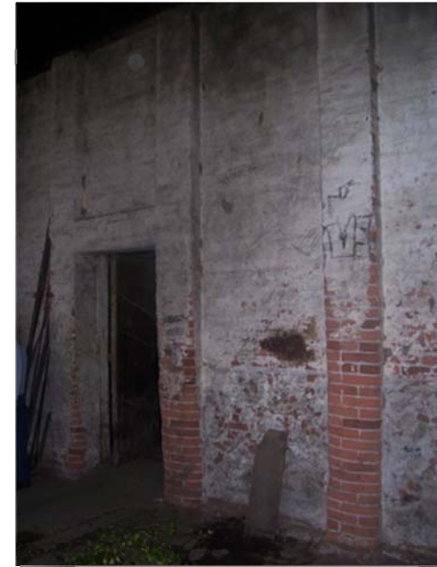
Foto #50. Muros ubicados en el primer nivel del edificio del Beneficio seco Fotografía: W. de Paz y A. Pérez
