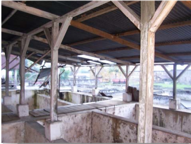
Foto #43. Columnas de madera . Sostienen el techo del Beneficio húmedo donde se encuentran localizadas las pilas de fermentación. Fotografía: W. de Paz y A. Pérez
