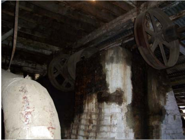
Foto #66. Columnas de ladrillo que sostienen el peso de maquinaria de dos niveles del Beneficio seco y es evidente el deterioro Fotografía: W. de Paz y A. Pérez
