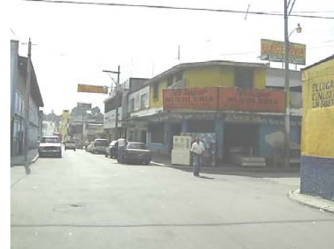
Visual urbana en deterioro
