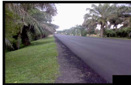
Carretera CA-2 vista hacia la entrada principal de la cabecera municipal y hacia la Frontera El Carmen.
